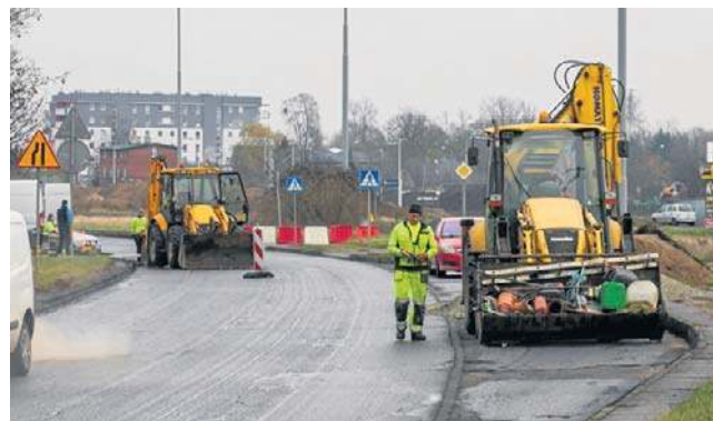
Prace remontowe rozpoczęto równolegle na ulicach Andersa i Akademickiej.
