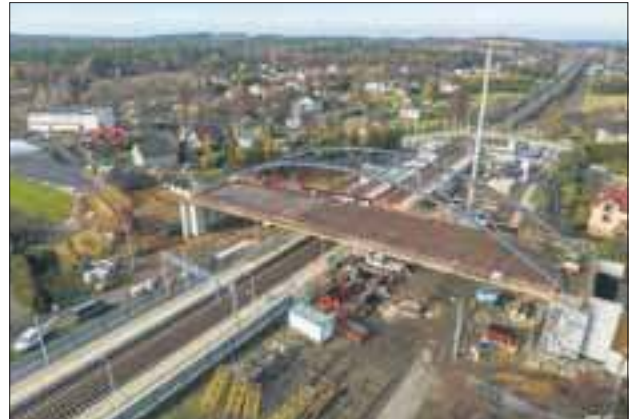
Wiadukt w Ciężkowicach
