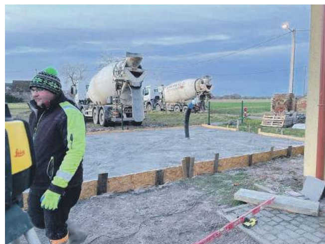
Szatnie modułowe sprawdziły się we Wszemirowie, dlatego podobna inwestycja powstaje w Krościnie Wielkiej
