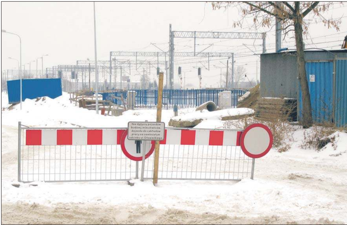
Zima przerwała prace przy budowie ronda u zbiegu ulic Głowackiego, Konarskiego i Staszica.
