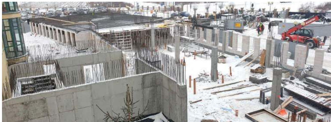
Zakończenie prac planowane jest na koniec 2021 r.
