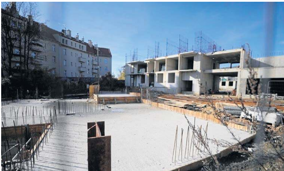
Tak wygląda obecnie plac budowy w Gliwicach na inwestycji, która rozpoczęła się niemal trzy lata temu
