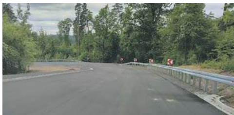
Wyremontowane serpentyny na Łysej Górze (droga z Alwerni do Grojca)
