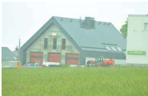
Nowa remiza przy Sobieskiego w Plazie
