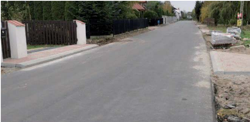
Grzegorz Rekiel Na ulicy Polnej trwają prace
