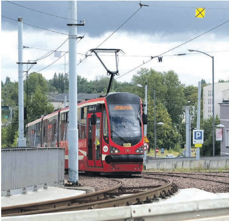
Testy techniczne wypadły dobrze, tramwaje wróciły na estakadę
