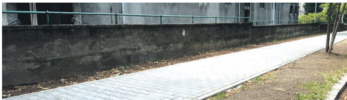
Odnowiony chodnik w rejonie kościoła św. Barbary
