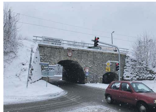
Wiadukt na ul. Siennej
