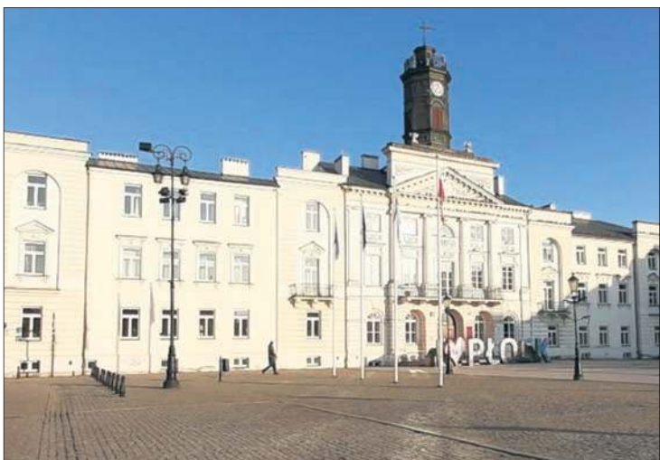
Elewacja głównego budynku płockiego ratusza wymaga remontu
