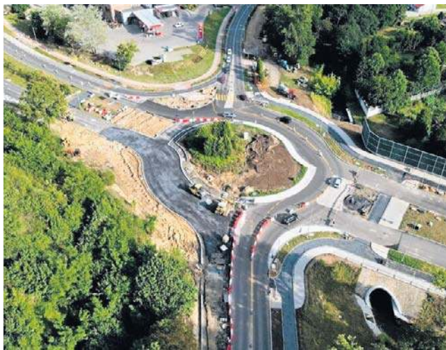
Niebawem budowa I etapu obwodnicy dobiegnie końca
