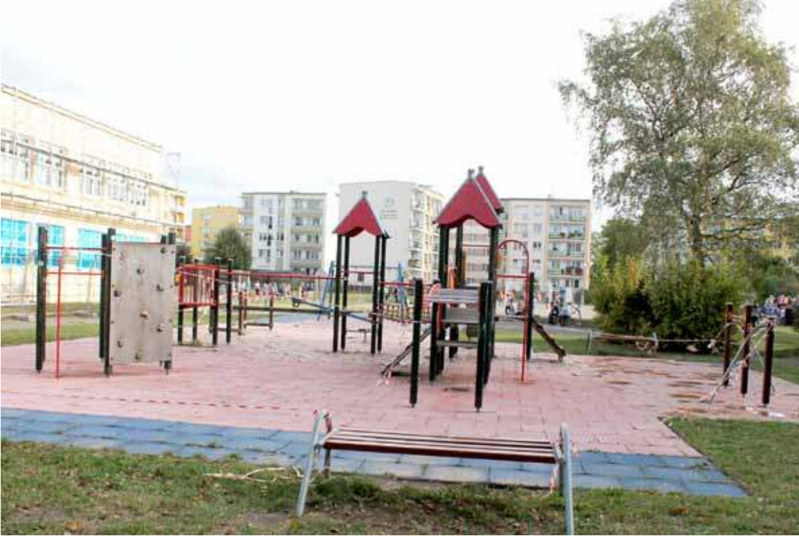
Owinięty resztkami taśmy zabezpieczającej plac zabaw przy SP 2 jest wyłączony z użytkowania, głównie przez złą kondycję nawierzchni amortyzującej
