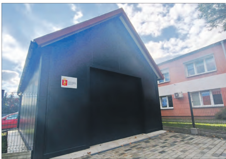
Nowy garaż przy PCPR w Prudniku
