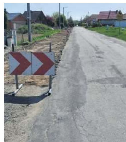
Rusza remont drogi powiatowej w Gościęcicach (gmina Strzelin)
