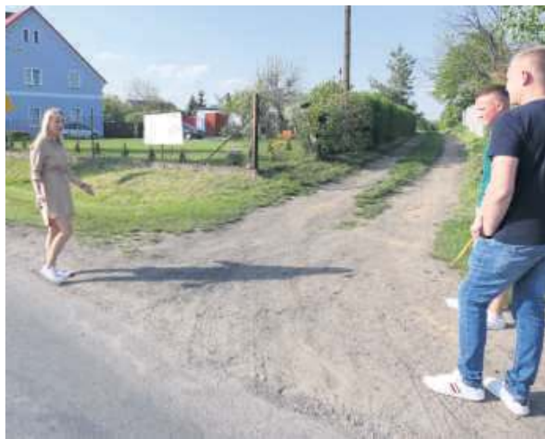
Droga gminna, prowadząca na plac zabaw, przylega do ruchliwej drogi powiatowej, przy której brakuje chodników. Zdaniem mieszkańców, zagraża to bezpieczeństwu najmłodszych
