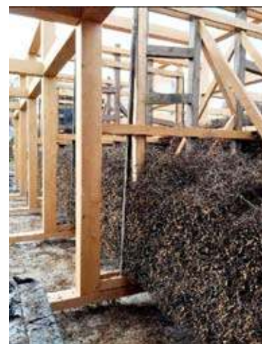
Porębska Tężnia również w budowie
