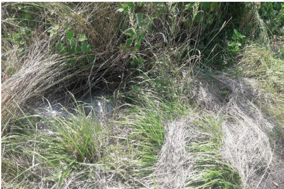
Tak wygląda przydrożny „rów wsiąkający” w którym woda stała jeszcze dwa dni po opadach
