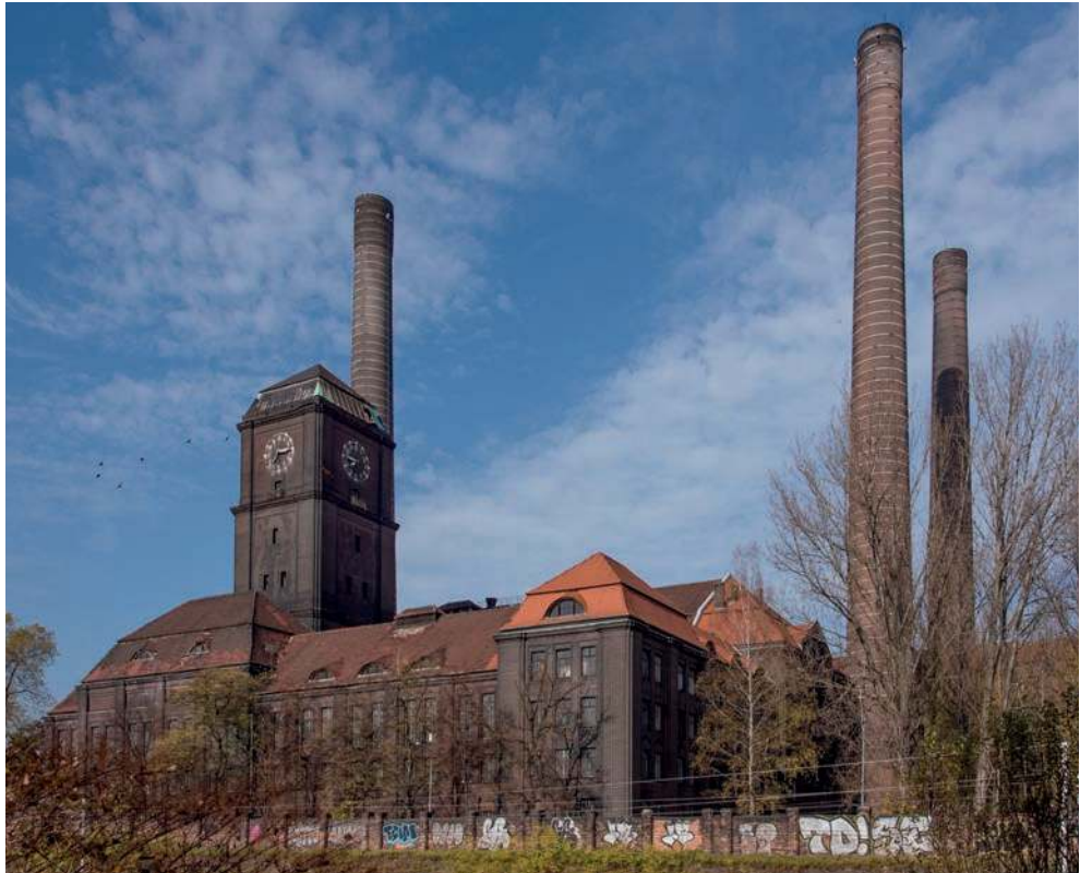
Bytomska Elektrociepłownia Szombierki
