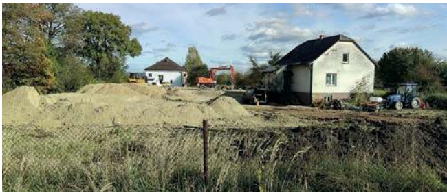
Plac budowy przy Chrzanowskiej w Balinie
