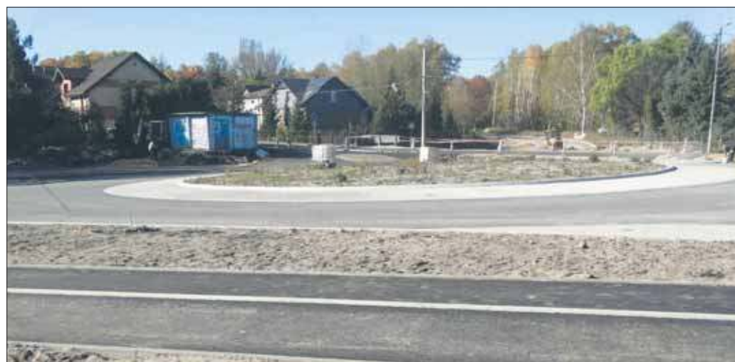
Budowa ronda na Nowoszczakowskiej
