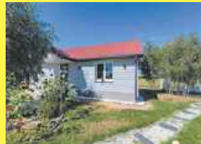
Dom z bala o powierzchni 80 m 2 na działce o po- wierzchni 821 m 2 , Porosi- uki, 885 851 161
