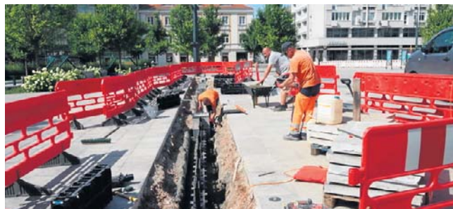
Robotnicy prowadzą też naprawy przy znajdującej się na placu fontannie.
