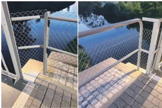
W miejscach, gdzie były wolne przestrzenie, zamontowano siatki
