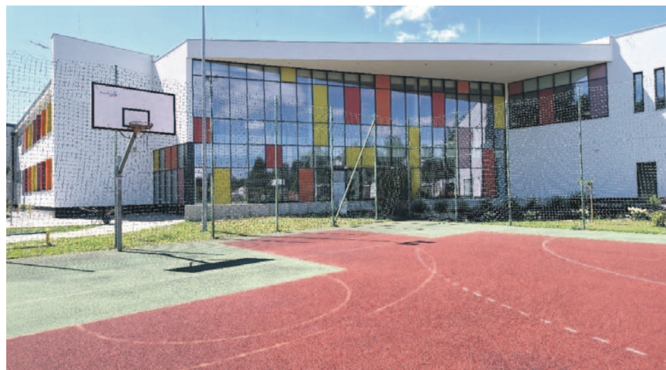
Program objął m.in. dofinansowanie remontu boiska przy PSP nr 1
