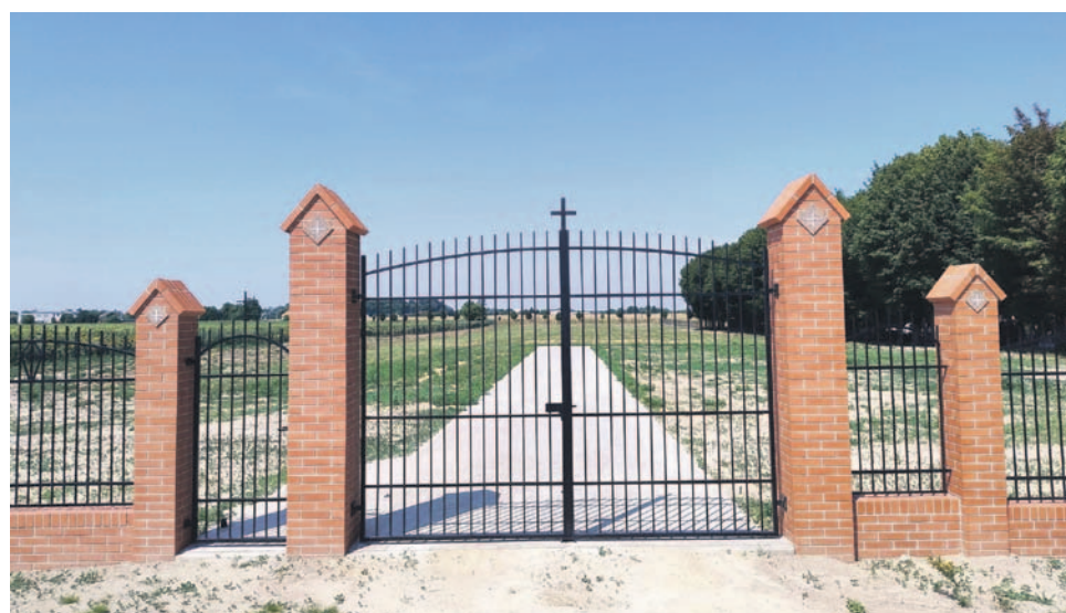
Nowe ogrodzenie chwałowickiego cmentarza
