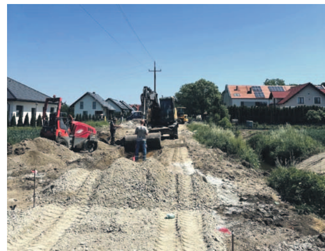
4 sierpnia gmina Domaniów odebrała kolejny etap budowy kanalizacji sanitarnej
