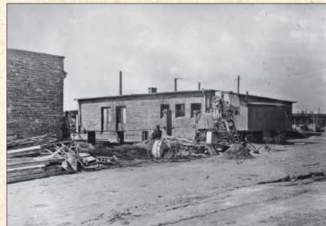
■ Budynki gospodarcze w czasie budowy
