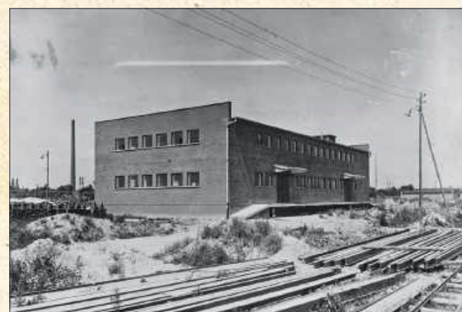
■ Ukończony budynek acetylenowni
