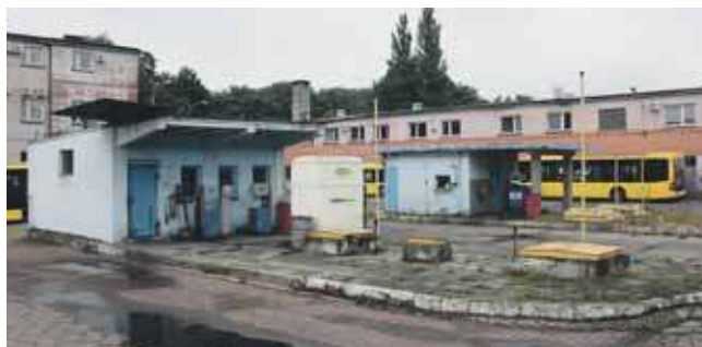
Baza PKM Świerklaniec powstała na przełomie lat 50. i 60.
