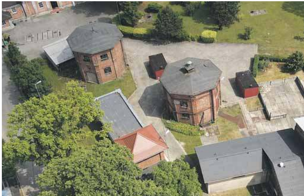
A na ziemi i w podziemiach jest co oglądać. Pomijając ciekawą, starą architekturę zabudowań, pozostałości wielkiej kotłowni na powierzchni, imponujące wrażenie robi to, co pod ziemią
