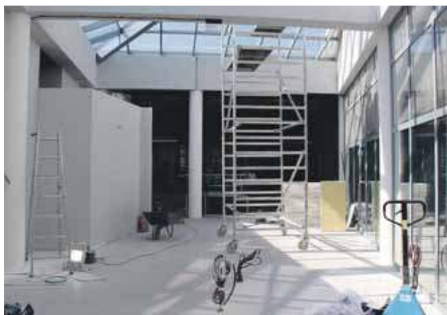
Na piętro zostanie przeniesiona siłownia
