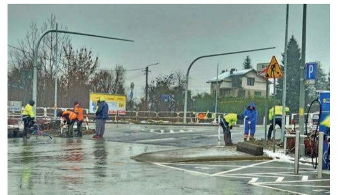
Trwa montaż świateł przy Lidlu
