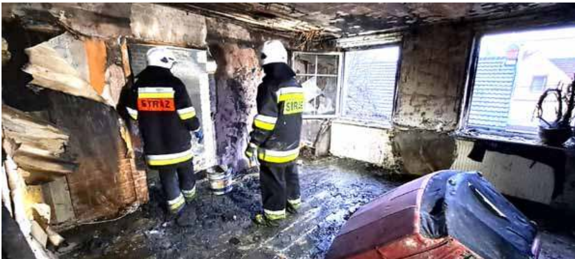
Po akcji gaśniczej uprzątnięto pomieszczenia z pozostałości po pożarze (fot. mł. asp. Dariusz Schacht)
