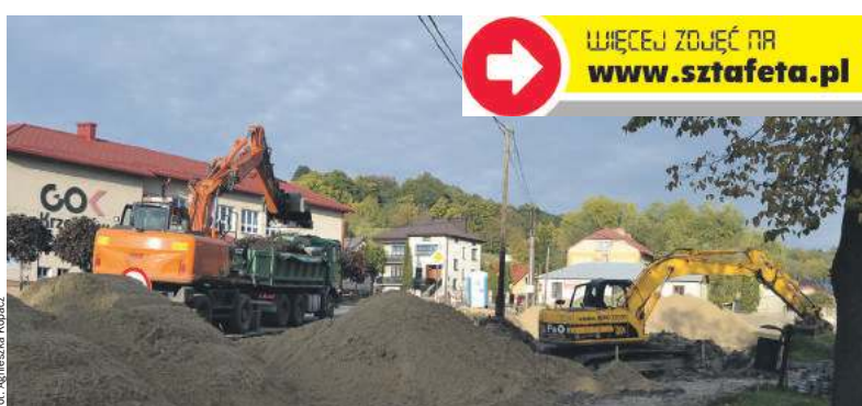
Prace przy budowie ronda na rynku w Krzeszowie według planów mają potrwać do połowy grudnia tego roku
