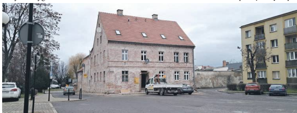
Modernizacja kamienicy przy Placu Piastów 3 rozpoczęła się w maju 2022 roku
