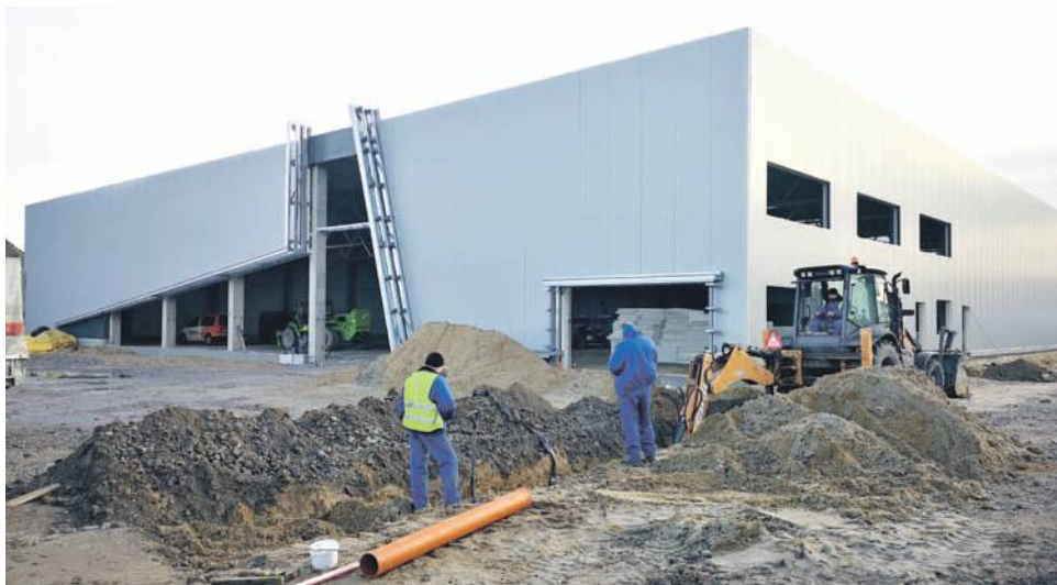
Bryłę już widać - teraz jeszcze prace w środku i na zewnątrz obiektu
