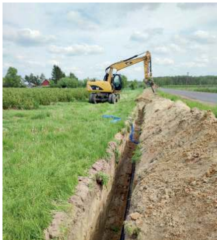
Budowa wodociągu na terenie Gminy Komarówka Podlaska dofinansowane ze środków Rządowego Funduszu Polski Ład Program Inwestycji Strategicznych
