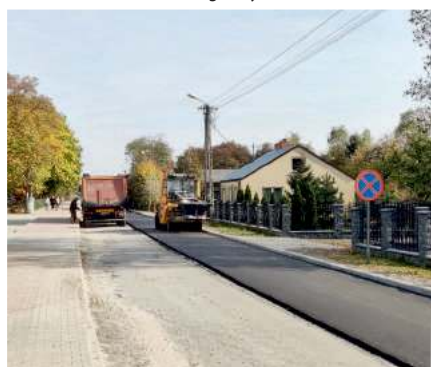
Budowa drogi ul. Wojska Polskiego dofinansowano z Rządowego Funduszu Rozwoju Dróg oraz Funduszu Przeciwdziałania COVID-19
