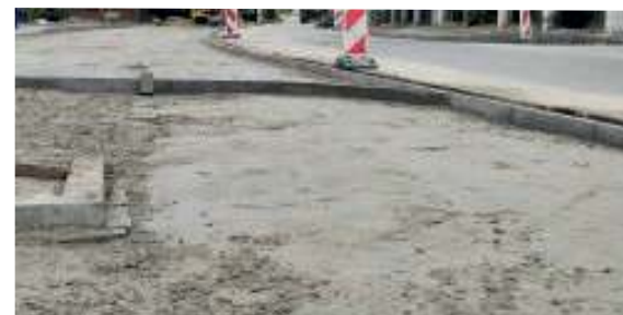
Remont ul. Krótka Dofinansowanie z Funduszu Dróg Samorządowych
