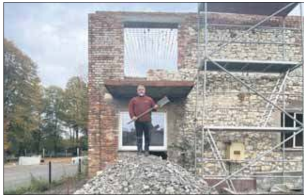
Ks. Tosza na placu budowy
