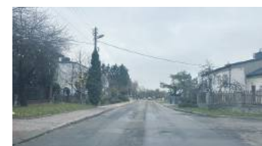
Ulica Mościckiego od dawna wołała o remont
