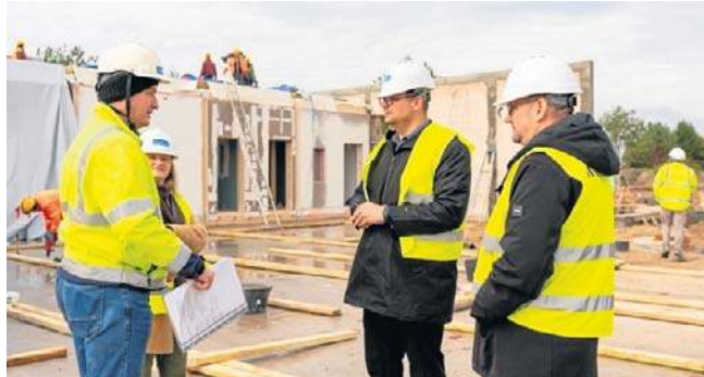
Trwa montaż „modułowego” żłobka
