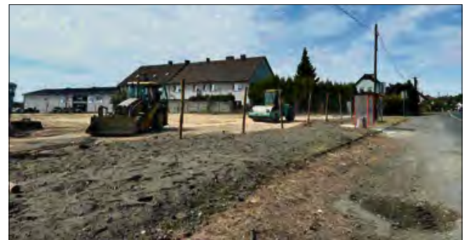
Na razie trwa przygotowanie placu budowy.
