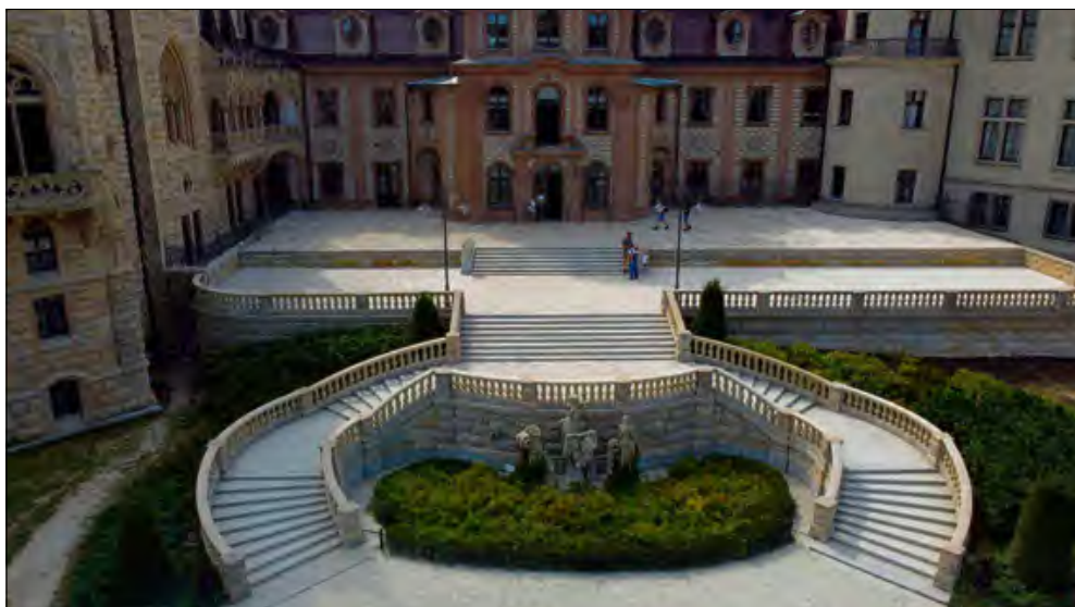
Tak prezentuje się taras po remoncie. Nawierzchnia wykonana z piaskowca aż lśni.
