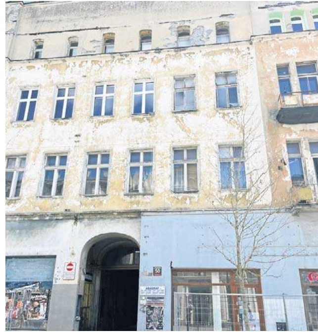
Kamienica przy ul. Piotrkowskiej 50 jest jedną z sześciu przy tej ulicy, które przejdą gruntowny remont
