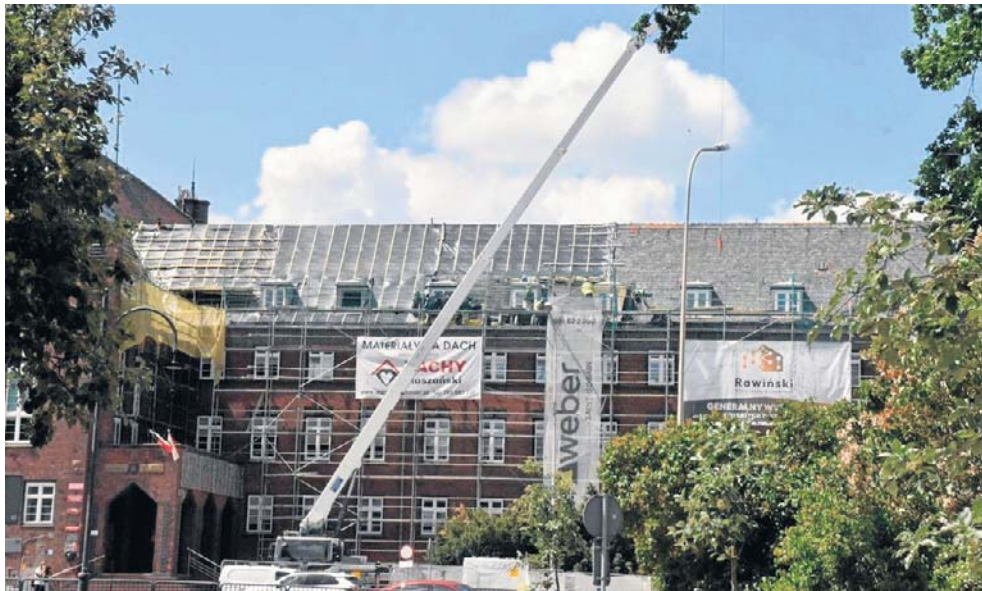
Prace na budynku UM Malborka obejmują m.in. wymianę 2302 m kw. dachu
