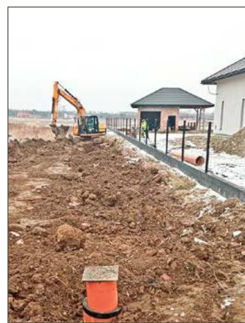
Nowe przyłącza w gminie Żyraków ciągle powstają.
