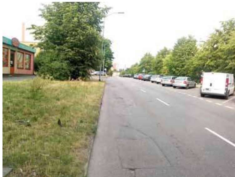
Zarząd Dróg Powiatowych zdecydował o tym, że przy ulicy Żeromskiego nie zostanie zamontowany próg zwalniający
