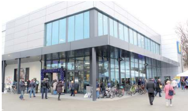
Nowy Lidl został otwarty 14 listopada o godzinie 7:00. Całkowita powierzchnia sklepu wynosi 1300 metrów kwadratowych
