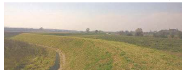
Fot. Andrzej Wróbel Chroniąca przed powodzią infrastruktura wykonana w ramach projektu na terenie miejscowości Dębica i Kędzierz.
