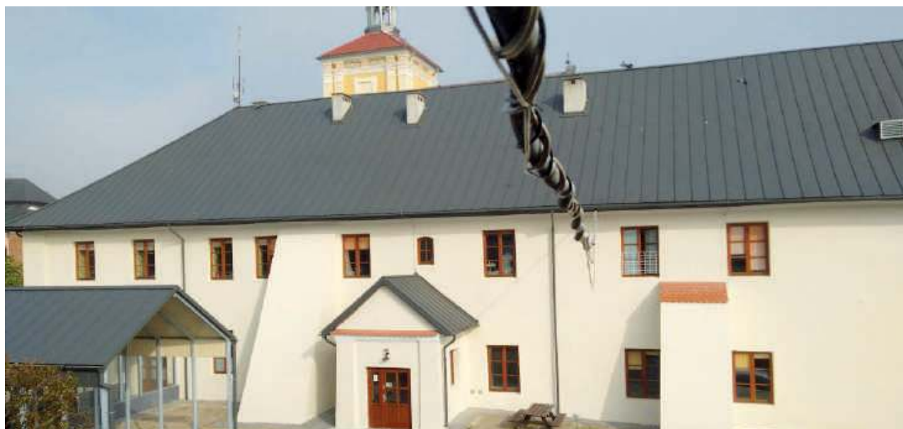
Budynek Szpitala w Szczepieszynie po remoncie elewacji.
