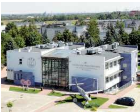
Budynek dydaktyczny ul. Zamoyskiego 64
