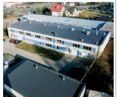
Budynek dydaktyczny ul. Szczepieńskiego 31
