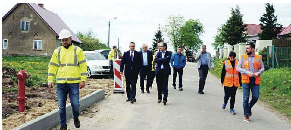
Z roboczą wizytą na inwestycjach drogowych
