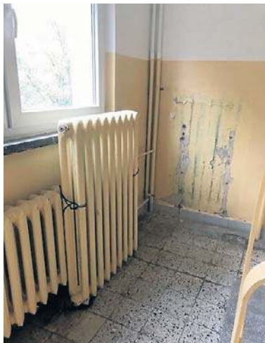
Kaloryfer usunięty ze ściany na klatce schodowej
