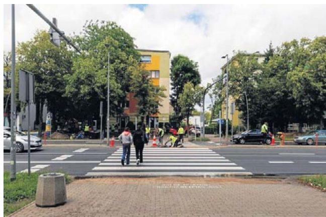
Prace przy budowie sygnalizacji ruszyły wczoraj
