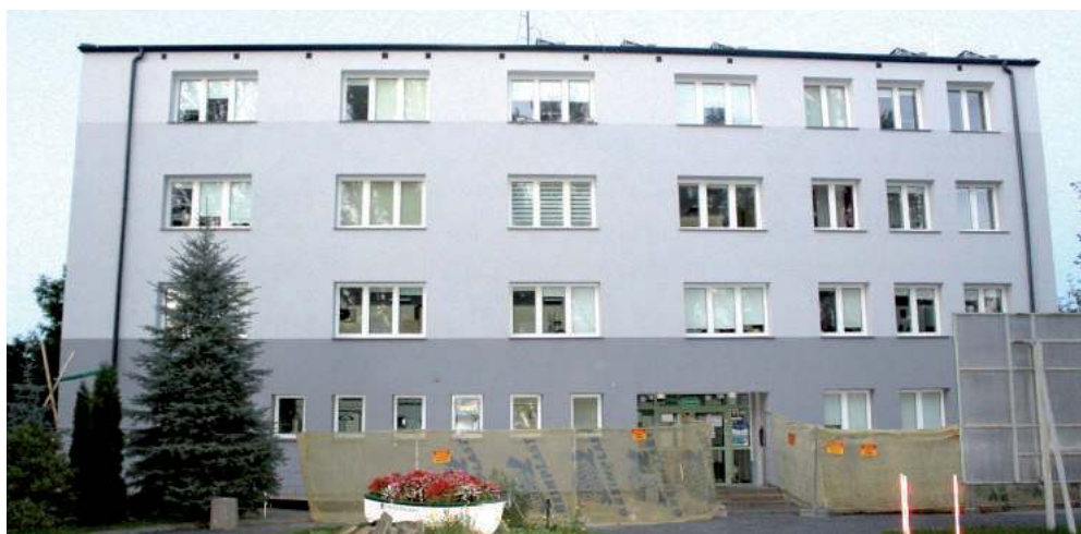
Urząd gminy w Puławach jest już w pełni ukończony. Zmianie uległa kolorystyka budynku - teraz zamiast zieleni królują na nim różne odcienie szarości
