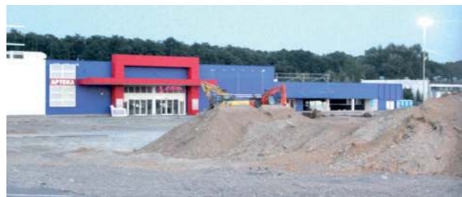
Teren przyległy do hali po Tesco został wygrodzony, zerwano istniejącą do tej pory nawierzchnię
