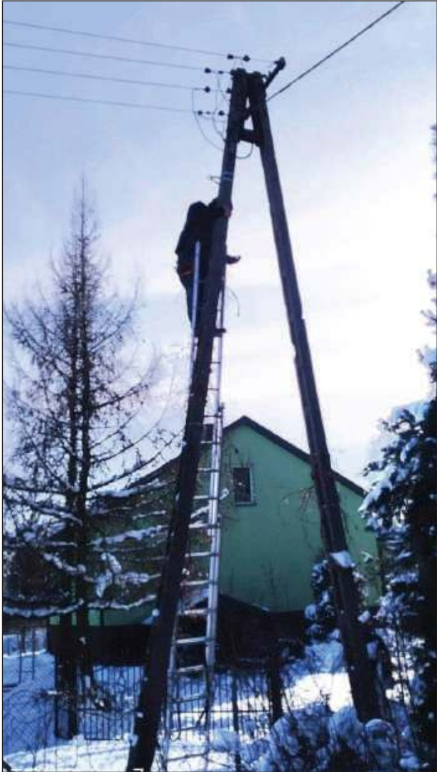
Trwa montaż platform internetowych na słupach w Ułężu i Żabiance
