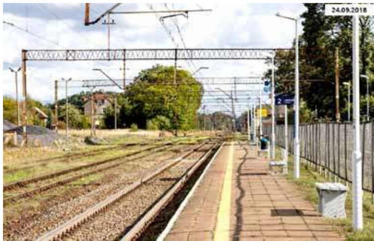
Stacja Dolice przed modernizacją fot. PKP PLK
