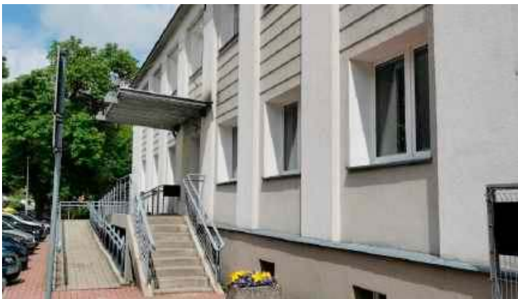
IAS kupiła budynek przy ul. Konopnickiej 3 za 3,5 mln. W jego przebudowę zainwestuje kolejne prawie 5 mln zł
