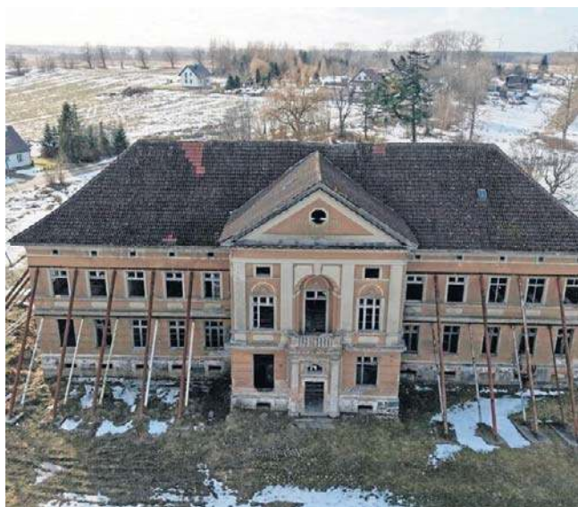
Zabytkowy pałac w Zdrzewnie jest w opłakanym stanie
