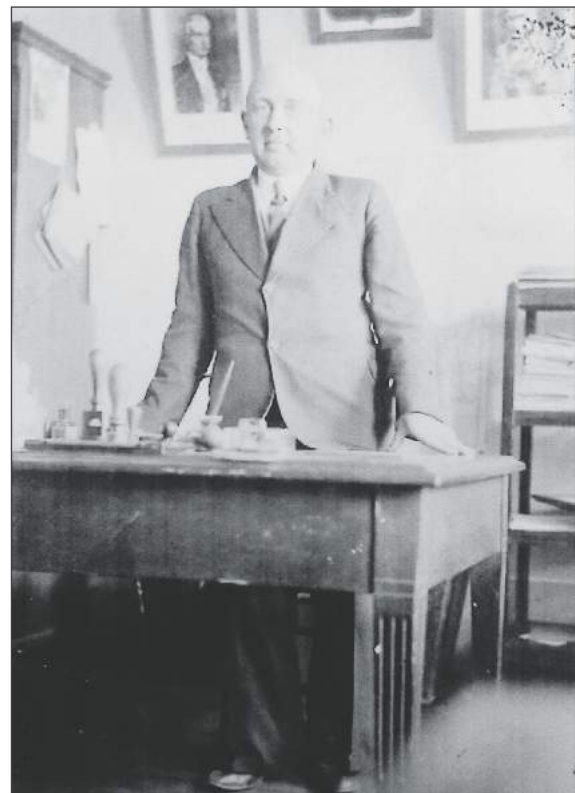
■ Stacją kolejową w Leopoldowie kierował zawiadowca Marian Smrokowski. W budynku dworca miał swój własny gabinet (zdjęcie ze zbiorów Janusza Rybaka)
